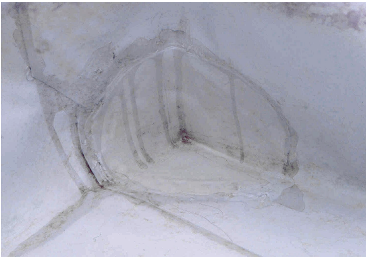
Abb. 4: Eckverstärkung mit vorgefertigten Formteilen
